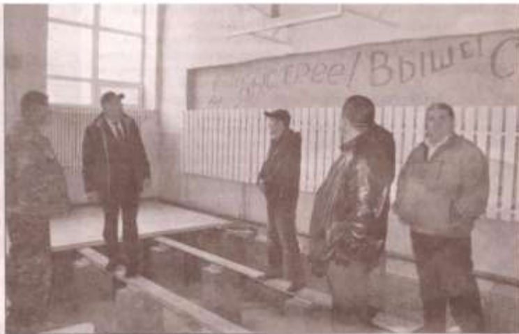
В Петропавловской школе гости осмотрели, как идет ремонт спортзала. фото: Л.ОГОРОДНИКОВА
